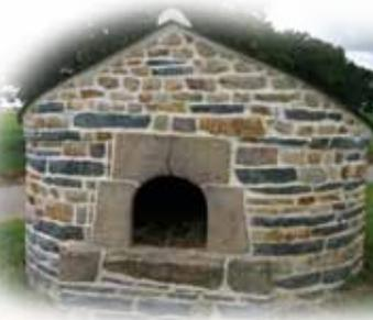
*Reflète de la géologie locale très variée, la maçonnerie de ce four est composée de schiste et de grès, avec gueule en granite.*
