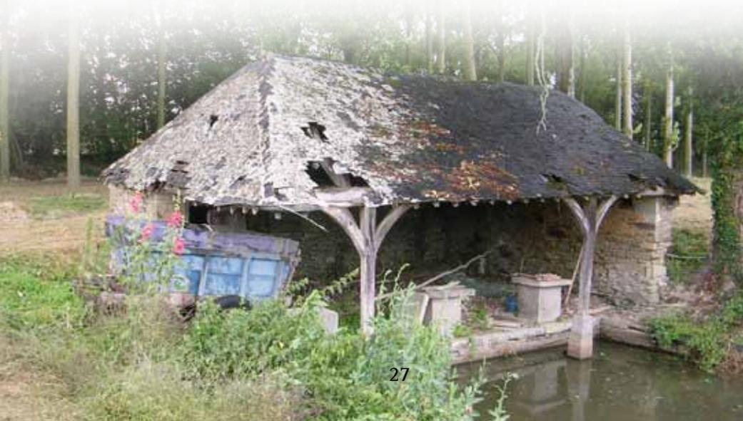
Le lavoir a été construit pour un bon écoulement de l'eau avec, en amont une alimentation en eau propre. En aval, l'eau sale s'écoule à l'opposé du bassin dans un ruisseau.
